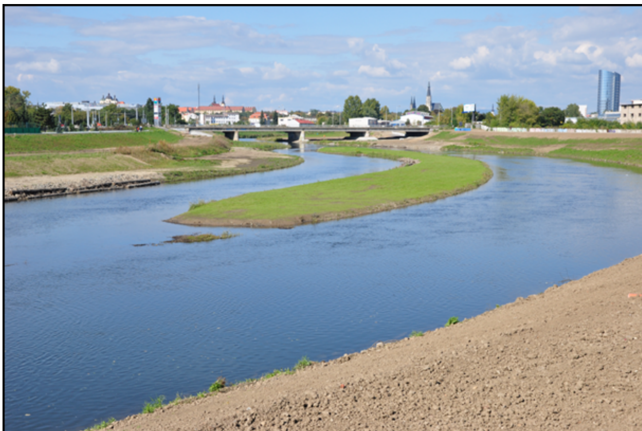
Druhá etapa protipovodňových opatření
